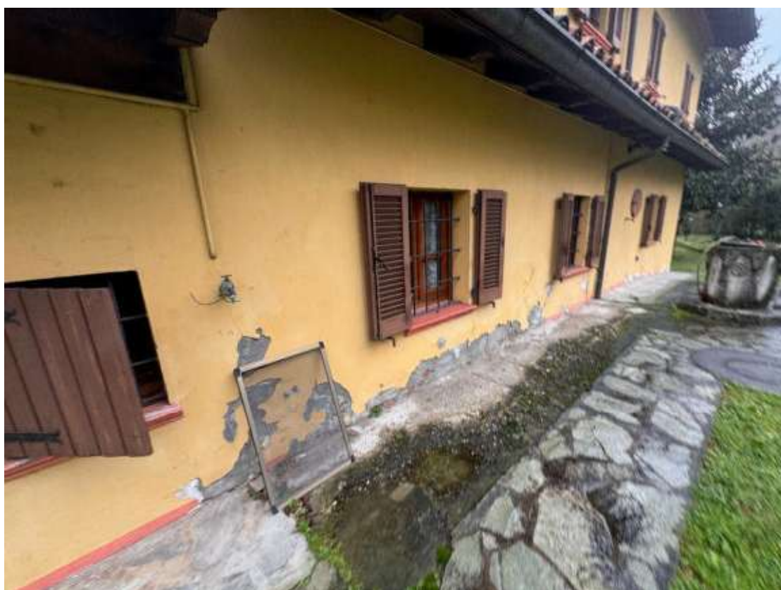
Vista Esterna Corpo di Fabbrica
