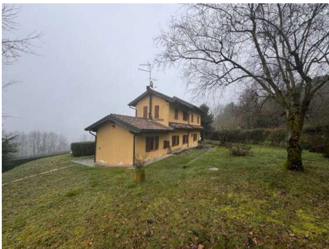
Vista Esterna Corpo di Fabbrica
