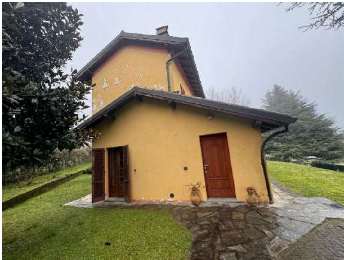
Vista Esterna Corpo di Fabbrica
