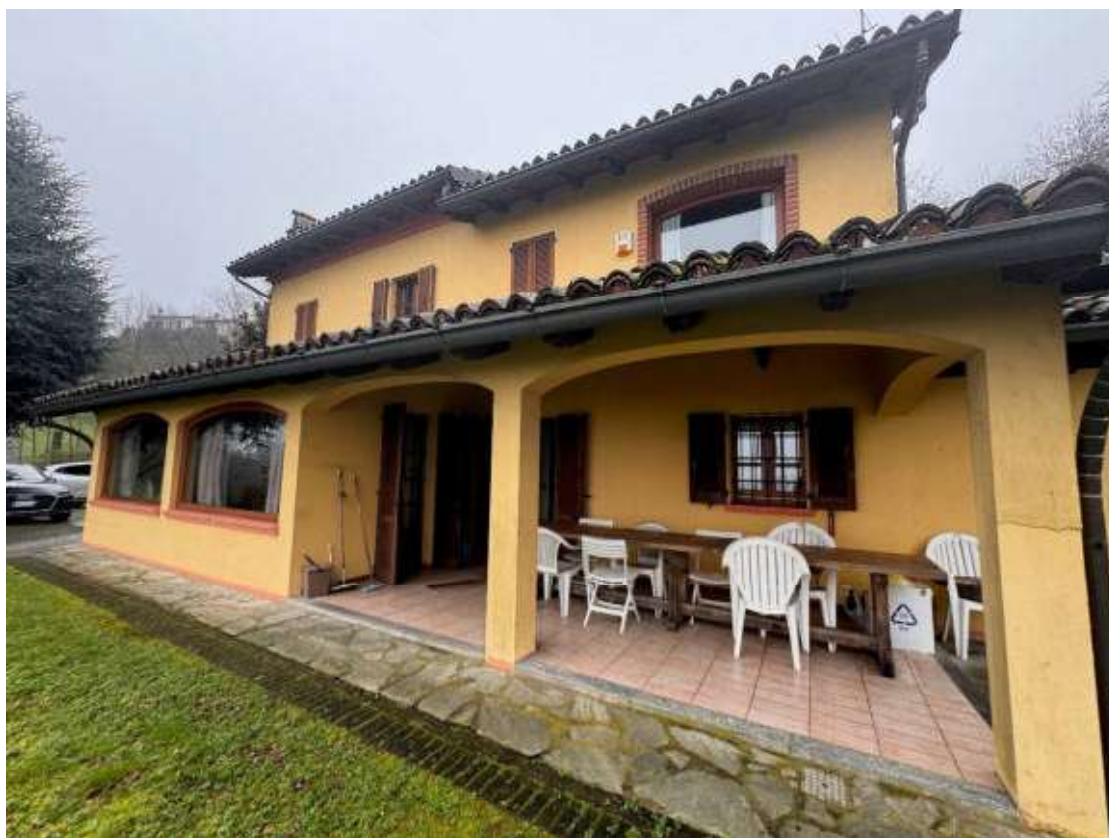
Vista Esterna Corpo di Fabbrica
