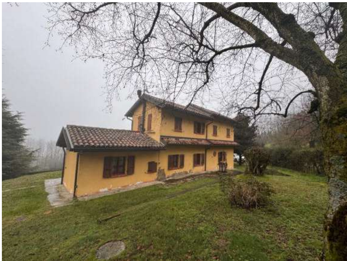
Vista Esterna Corpo di Fabbrica
