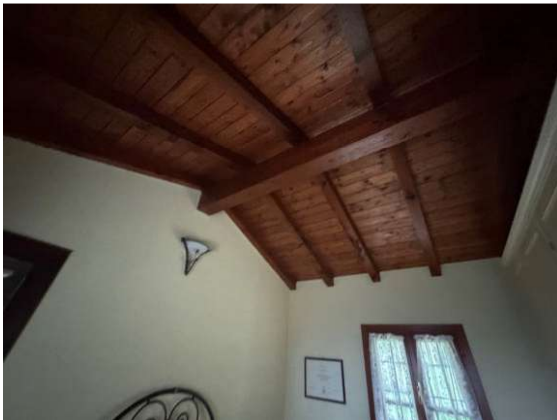
Camera da Letto n.1 : particolare soffitto travi a vista
