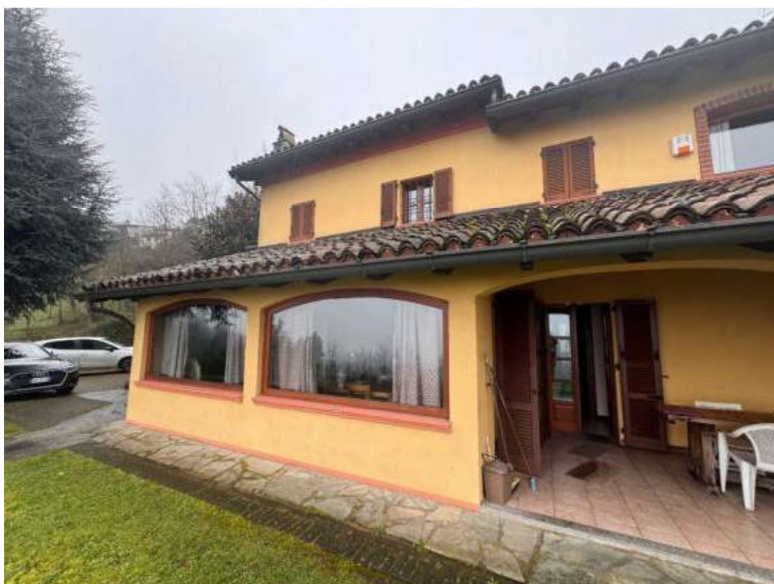
Vista Esterna Corpo di Fabbrica
